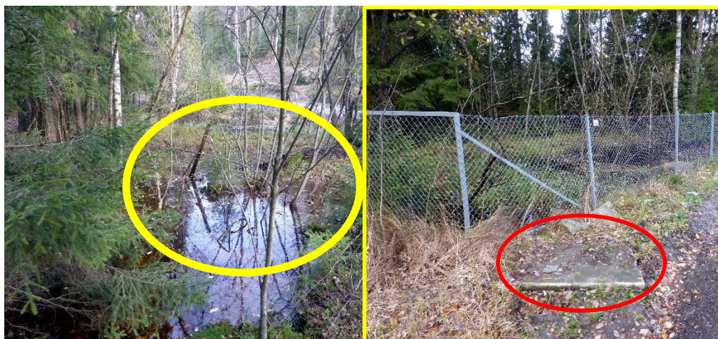
Figur 4. Dammen er i dag kraftig gjengrodd og er i ferd med å tape sin verdi for salamanderen. I grøftkanten ligger en betongkum som trolig ble anlagt i forbindelse med vannforsyning. Kummen kan være trafikkfarlig og et uønsket dreneringspunkt for dam.
