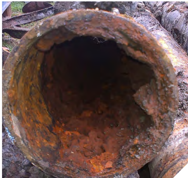
Gamle vannrør byttes ut i Ragnhildsvei
