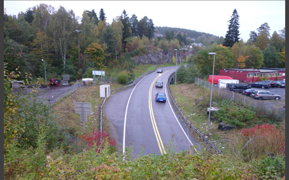
riksveg 159 går inn i Blåkollstunnellen
