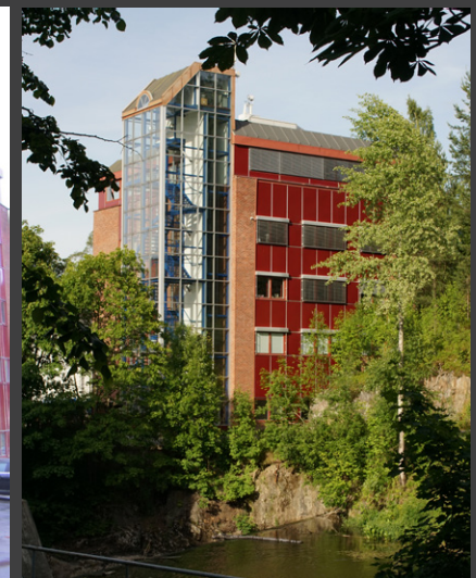
kontorbygg fra sør
