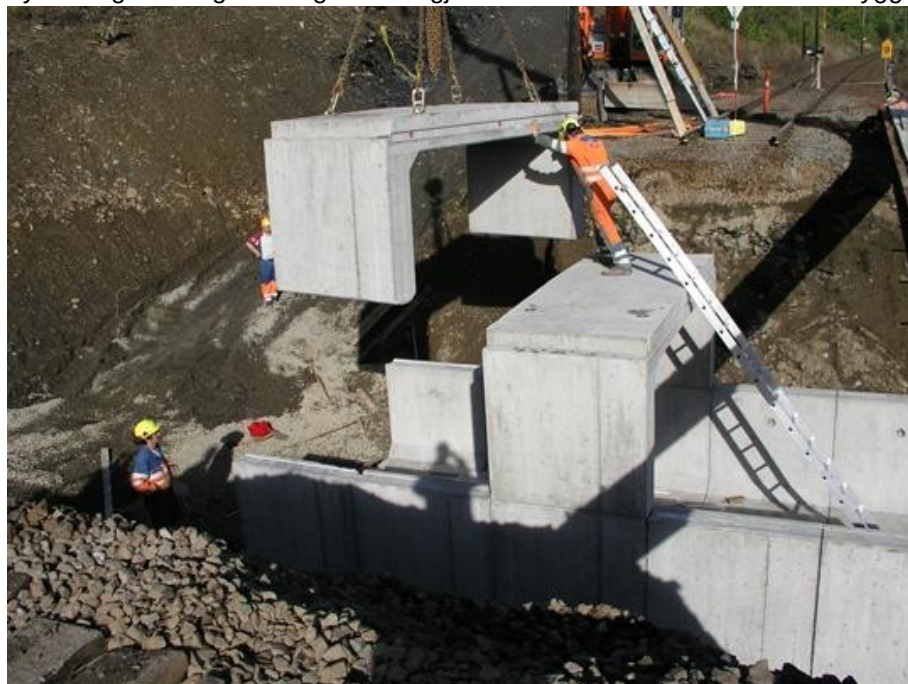
Figur 4 - Eksempel på montasje av elementkulvert.
