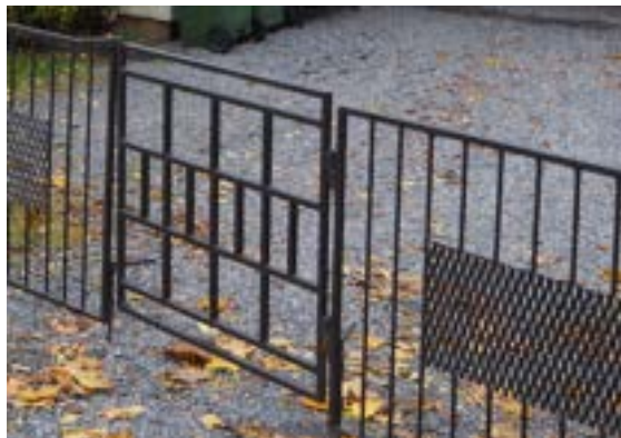
Ringveien 20, grind. Foto: Bjørn Johansen, NIKU 2016
