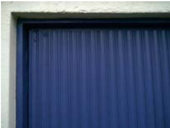
Ringveien 9, garasjeport. Foto: Siv Leden, NIKU 2016.
