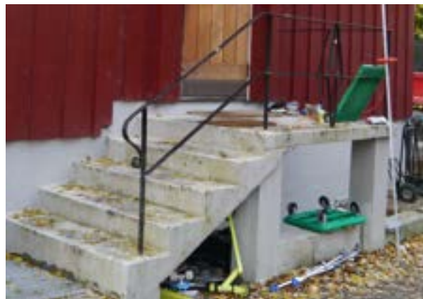
Skårerveien 65, betongtrapp. Foto: Siv Leden, NIKU 2016.
