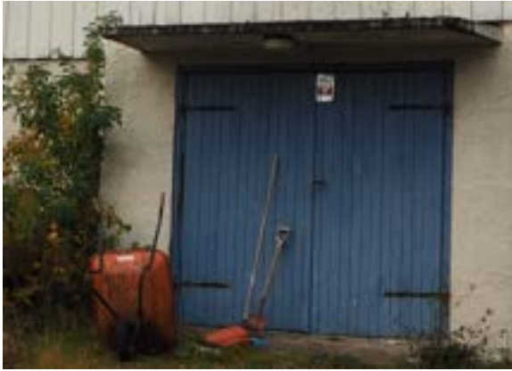
Bråtaveien 6, garasjeport. Foto: Bjørn Johansen, NIKU 2016
