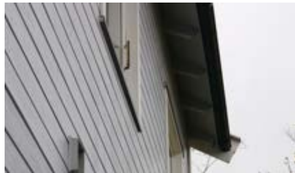
Torbjørns vei 20, taksperrer. Foto: Siv Leden, NIKU 2016.
