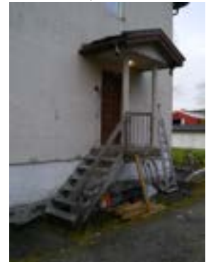
Skårerveien 69. Det eldre inngangspartiet var elegant utformet. Bæringen er kuttet og det henger nå i løse lufta. Foto: Siv Leden, NIKU 2016.
