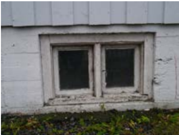
Skårerveien 77, kjellervindu. Foto: Siv Leden, NIKU 2016.
