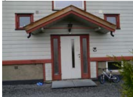
Ole Reistads vei 1, tak over inngang, trolig med opprinnelig bærekonstruksjon. Foto: Siv Leden, NIKU 2016.
