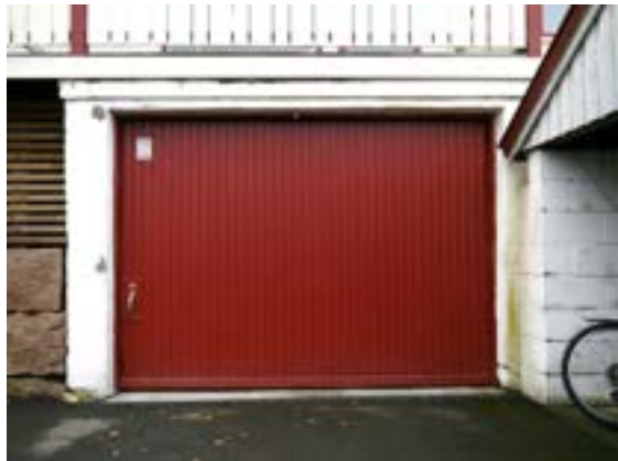
Ringveien 9, garasjeport. Foto: Siv Leden, NIKU 2016.
