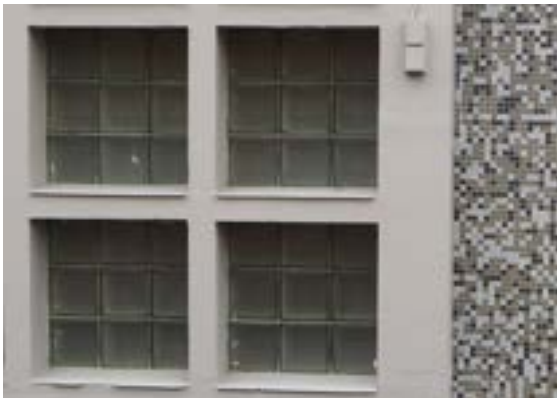
Lørdagsrudveien 24, glassbygggesten og fasademosaikk. Foto: Bjørn Johansen, NIKU 2016.
