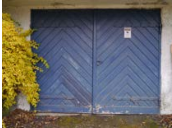
Ringveien 7, garasjeport. Foto: Siv Leden, NIKU 2016.
