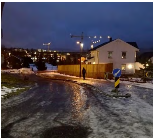
FIGUR 13 Gangforbindelse mot Vallerudveien, sett fra vest.
