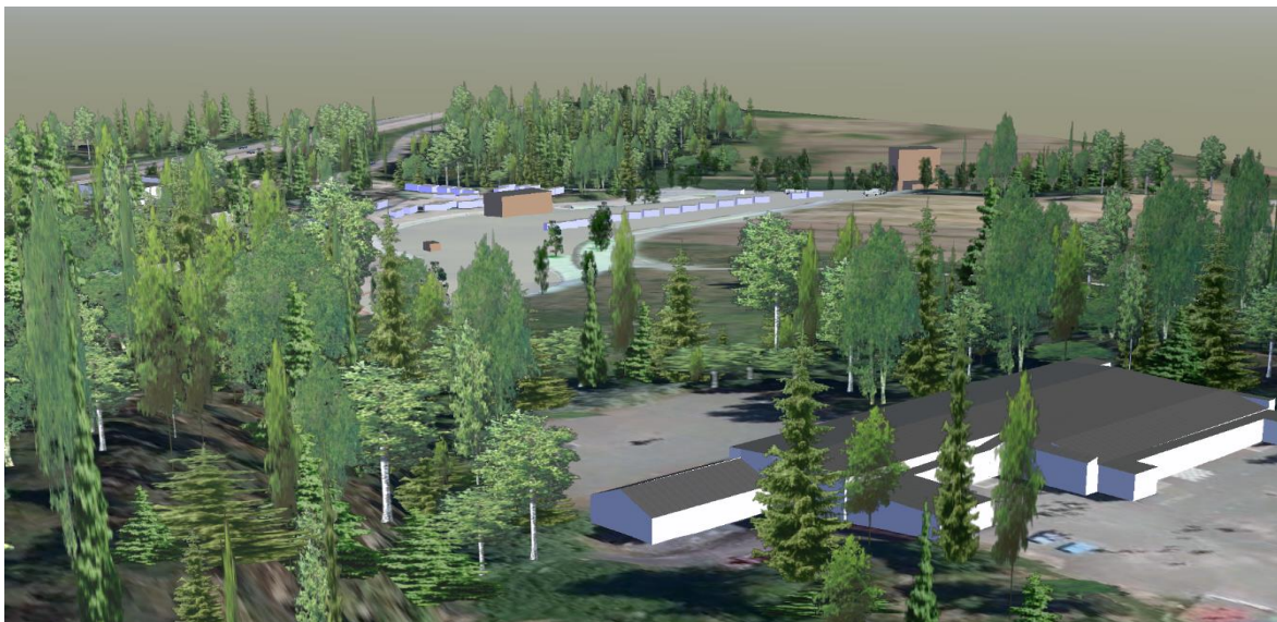
Gjenvinningsanlegget sett fra blokkbebyggelsen på Skåreråsen. Åsen skole i forgrunnen.
