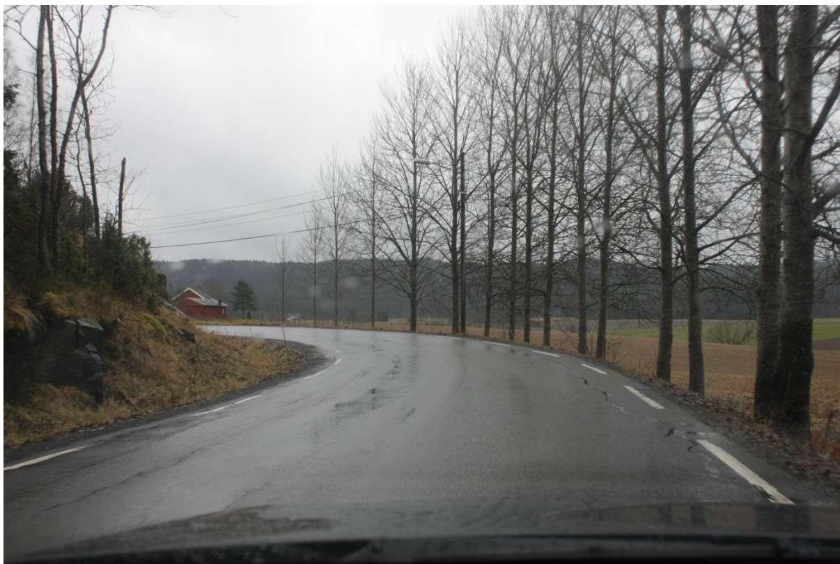
Fig. 2 Losbyveien er smal og stedvis uoversiktlig
