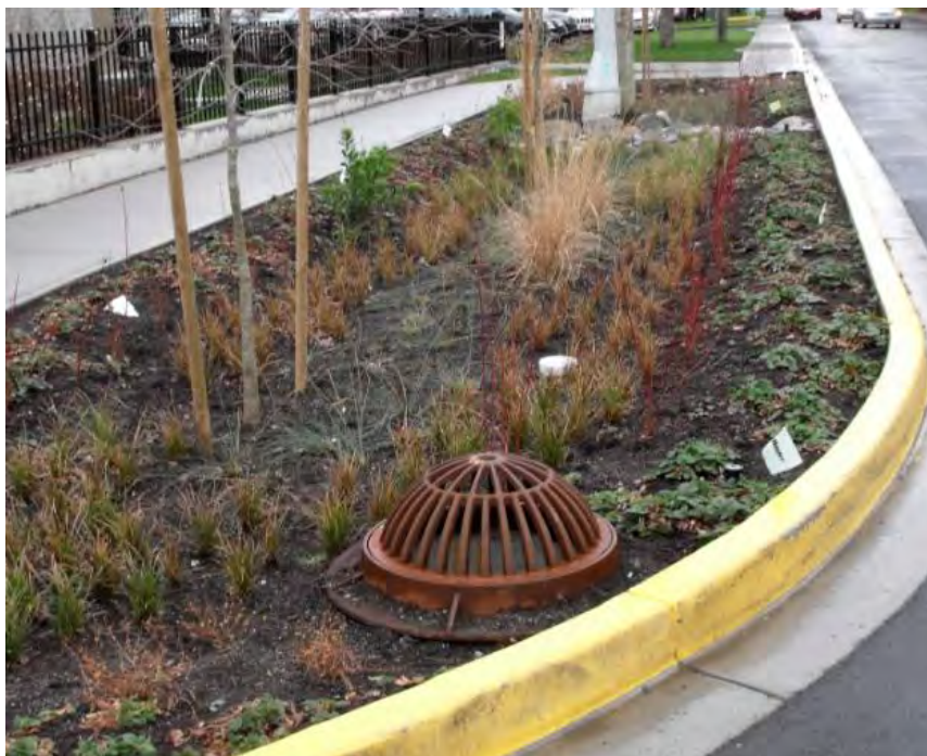
Figur 13 Eksempel på sandfang til overløp
