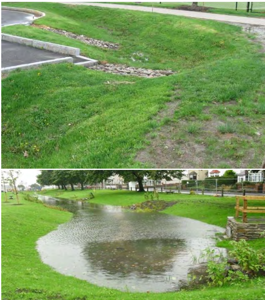
Figur 11: Illustrasjon av infiltrasjonsbasseng, ved tørrvær og større regnskyll (Google)
