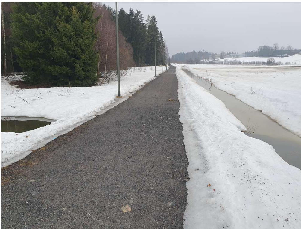
Figur 6 Turvei mellom Nordliveien og Losbyelva ved befaring 1.3.24.
