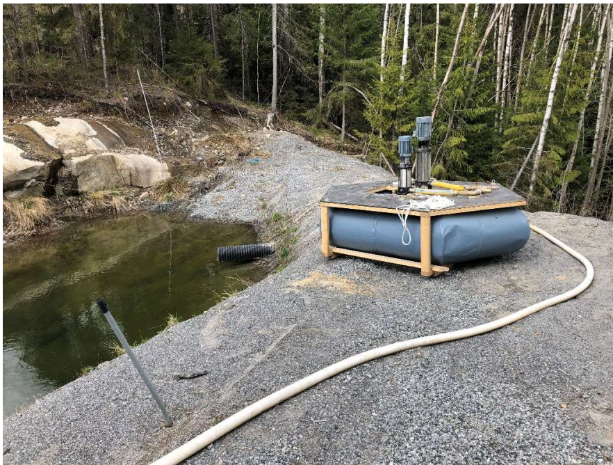
Sedimentasjonsbasseng med overløp til Losbyelva (sett mot nord)
