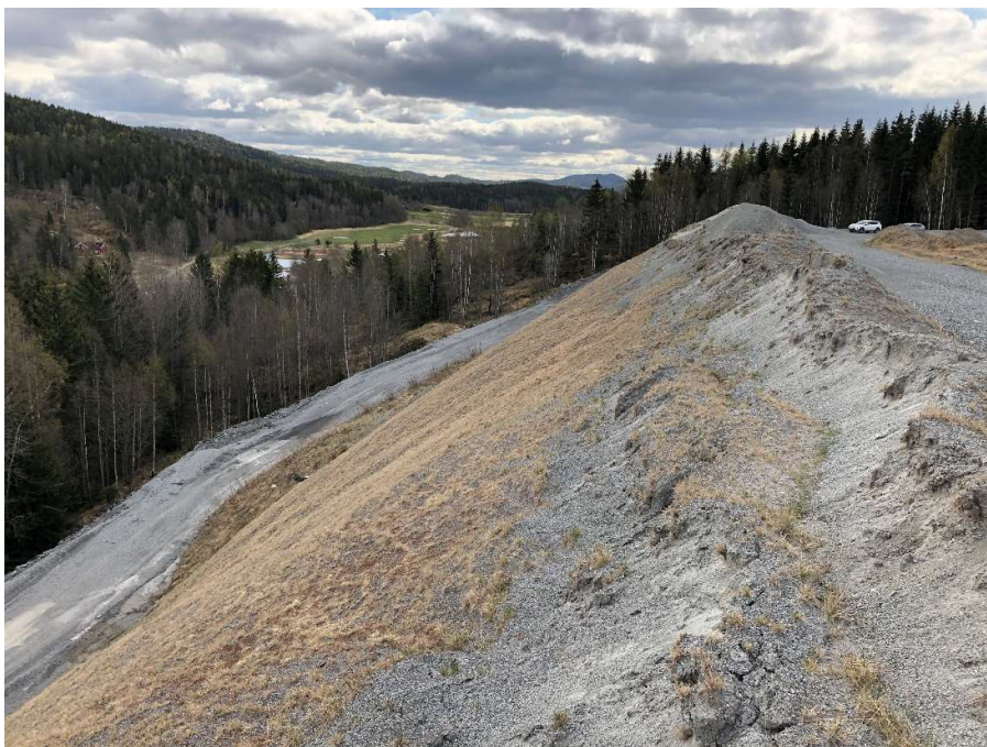
Løsmassevoll med vei/avsats mot øst (sett mot syd)
