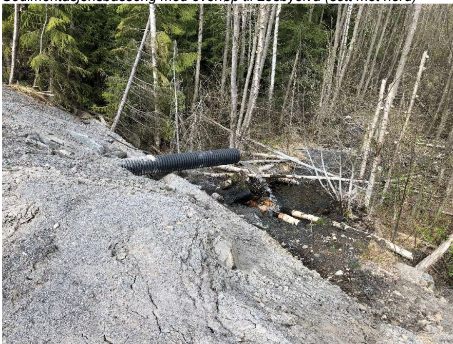
Sedimentasjonsbasseng med overløp til Losbyelva (sett mot nord)
