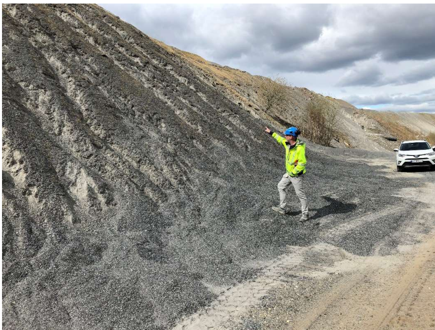
Utvasking/erosjon av finstoff i voll mot øst (sett mot nord)
