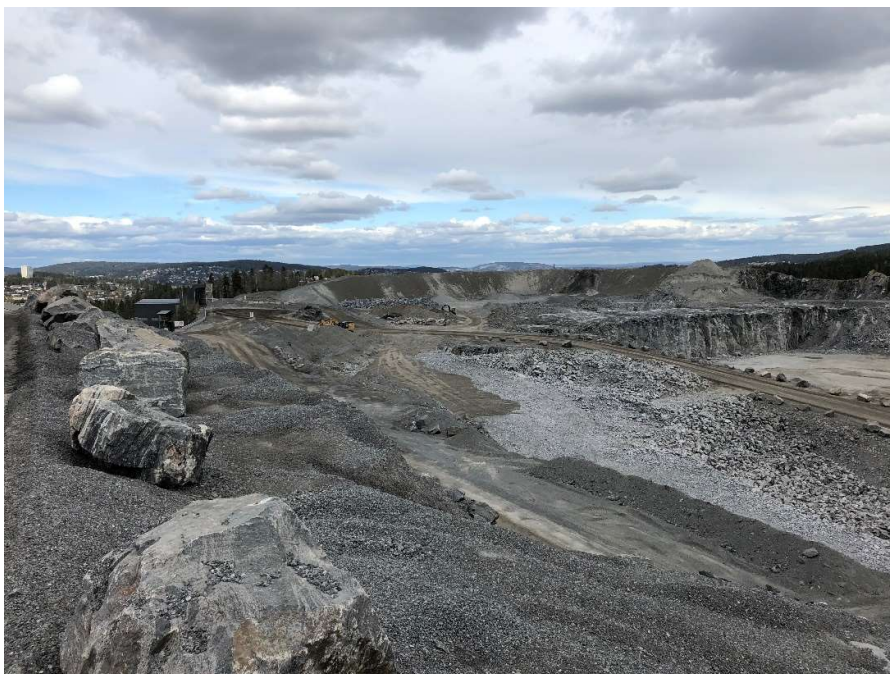
Oversiktsbilde av steinbrudd (sett mot nordøst), voll med finstoff sentralt på bildet
