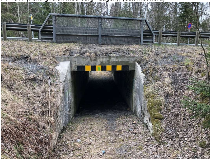
Kulvert under Fv 1517 (Feiringveien), (sett mot øst)
