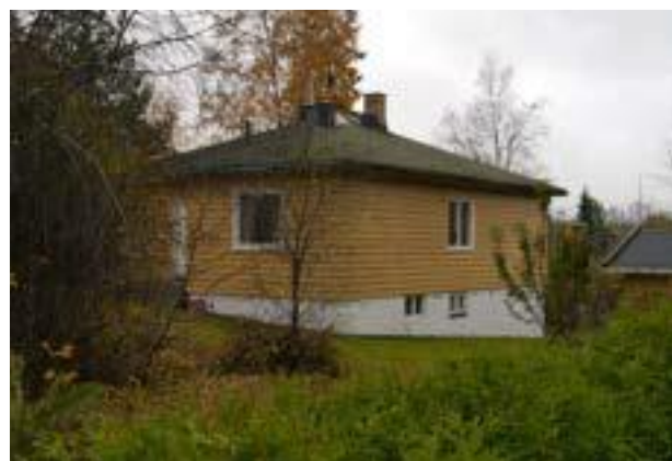
Fig 14 - Blåkollveien 2 (bevaringskategori A) sett fra Foto: Siv Leden, NIKU 2016.
