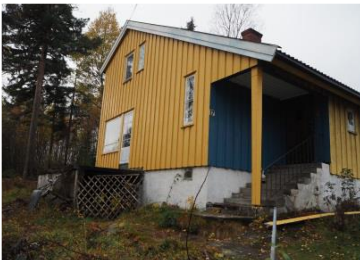
Fig 16 - Ringveien 17 (bevaringskategori A) sett fra sørøst. Foto: Bjørn Johansen, NIKU 2016.
