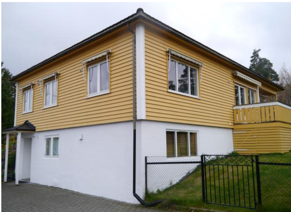
Fig 15 - Ringveien 11 (bevaringskategori B) sett fra nordvest. Foto: Siv Leden, NIKU 2016.
