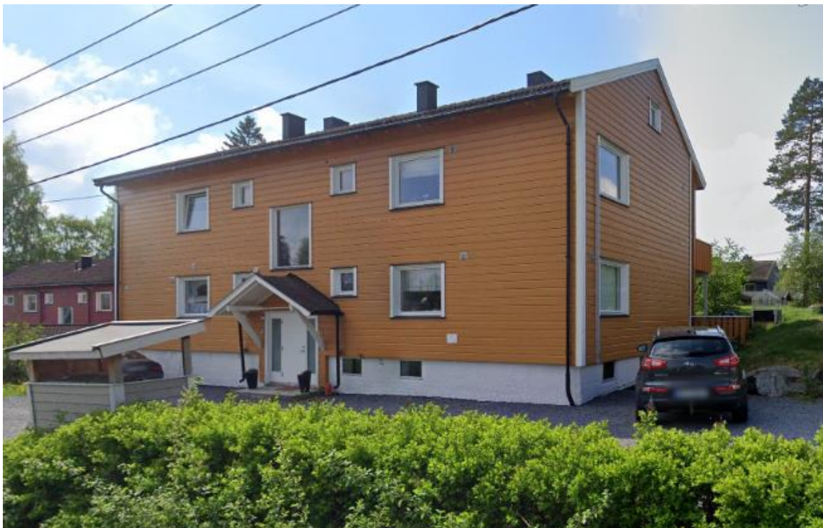
Fig 17 - Firemannsbolig i Bråtaveien 12, (bevaringskategori B). Foto: Google street view
