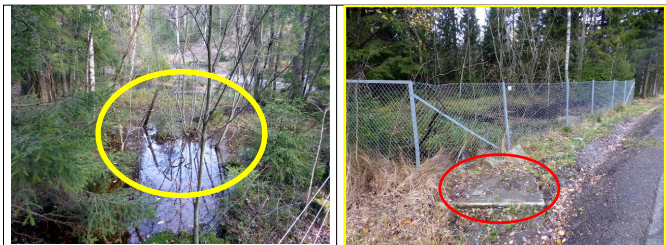
Figur 4. Dammen er i dag kraftig gjengrodd og er i ferd med å tape sin verdi for salamanderen. I grøftekanten ligger en betongkum som trolig ble anlagt i forbindelse med vannforsyning. Kummen kan være trafikkfarlig og et uønsket dreneringspunkt for dammen i tørre perioder.
