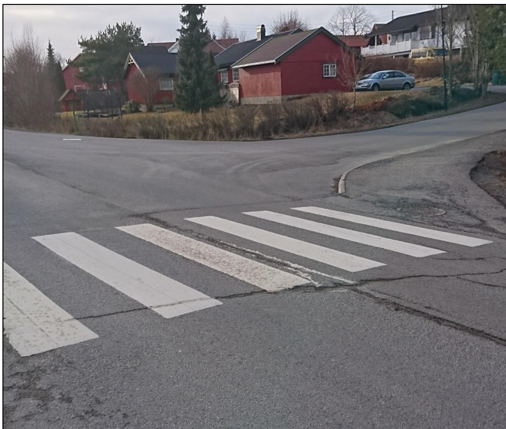
Figur 11: Gangfelt over Gamleveien ved Løkenåsveien, sett mot vest, fotografert mars 2017
