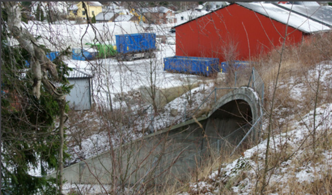
riksveg 159 går inn i Blåkollstunellen lager/ industribygg nr. 7
