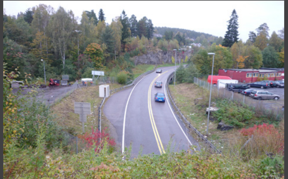
riksveg 159 går inn i Blåkollstunellen
