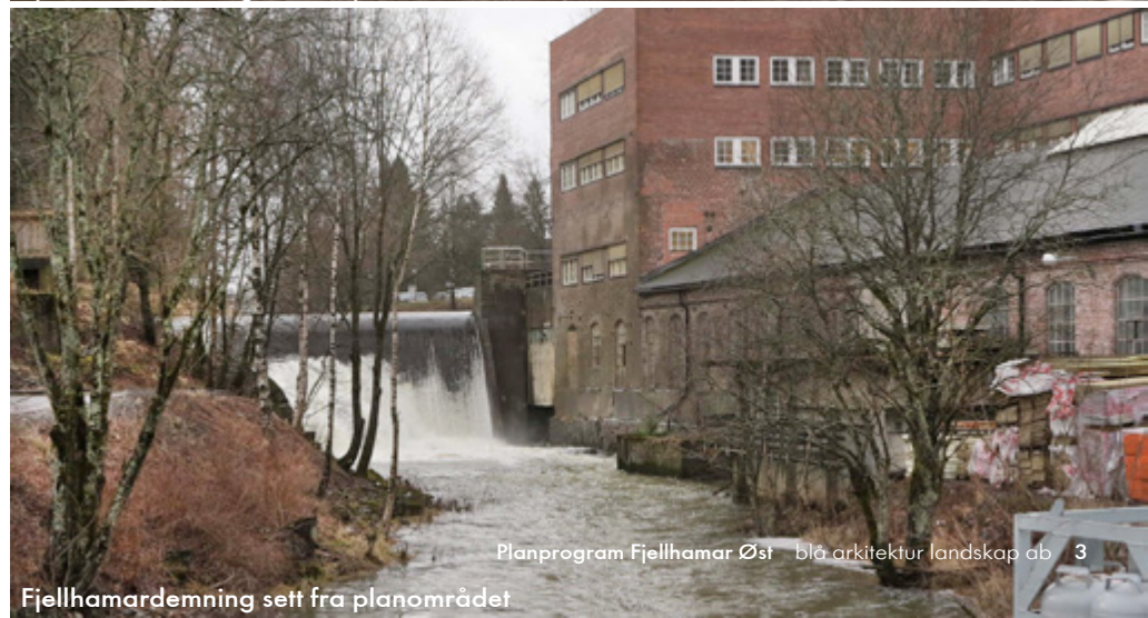
Fjellhamardemning sett fra planområdet
