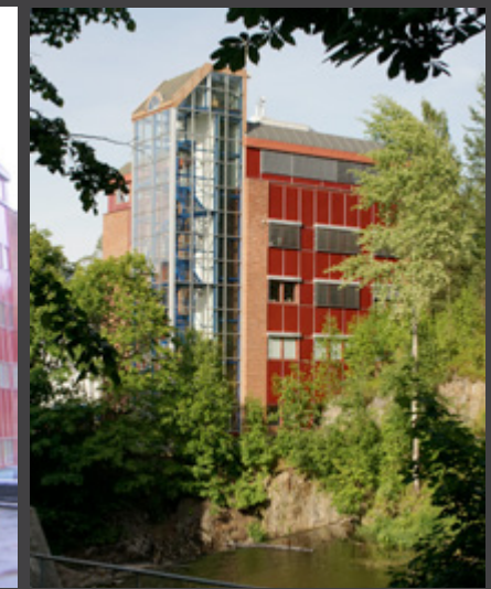
kontorbygg fra sør
