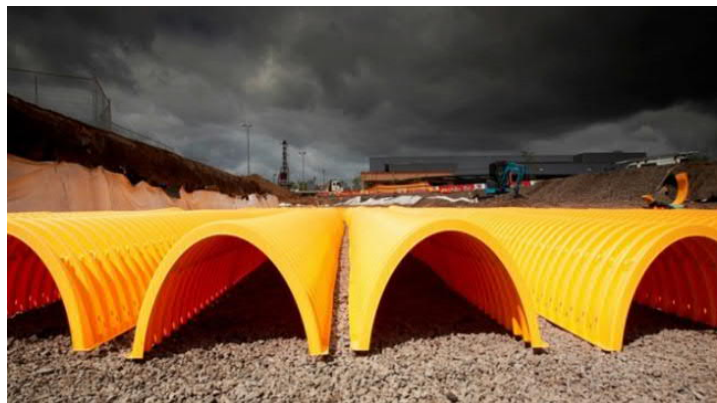
Figur 10: Stormtech fordrøyningsmagasin, utklipp fra VAsystemer sin hjemmeside.
