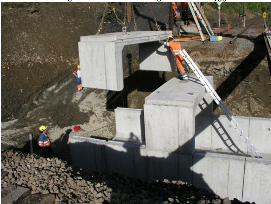
Figur 5: Eksempel på montasje av elementkulvert.
