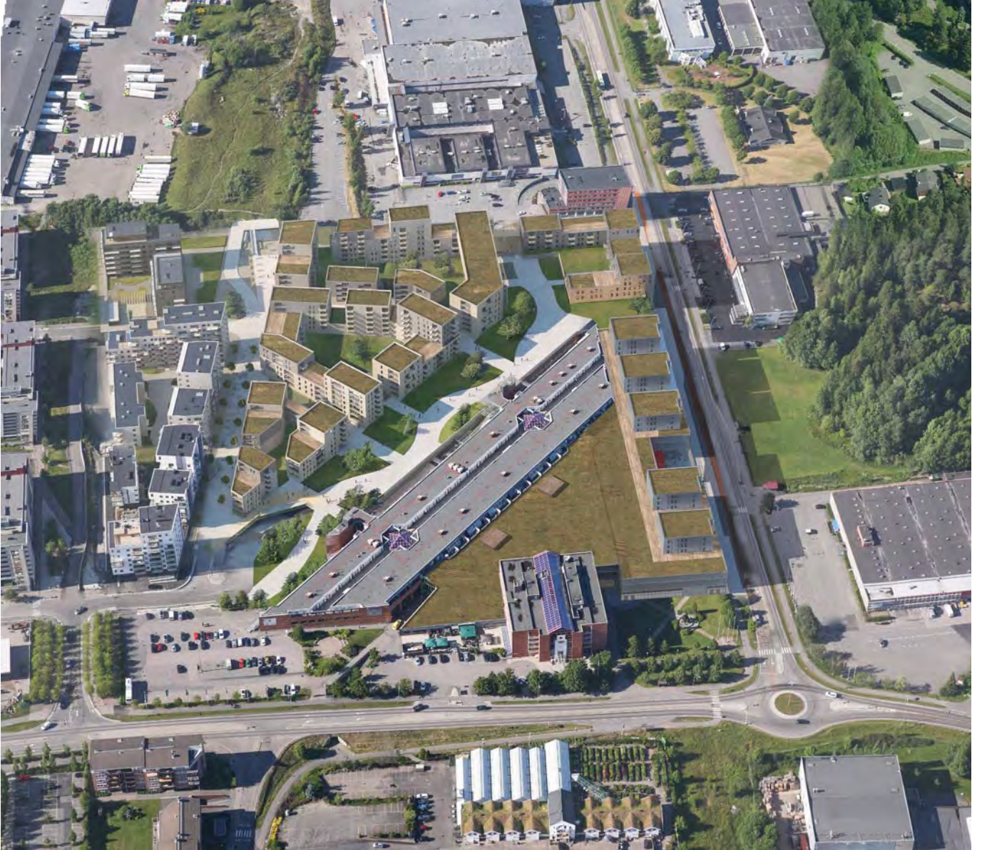
Oversiktsperspektiv innmontert på skråfoto, sett mot nord
