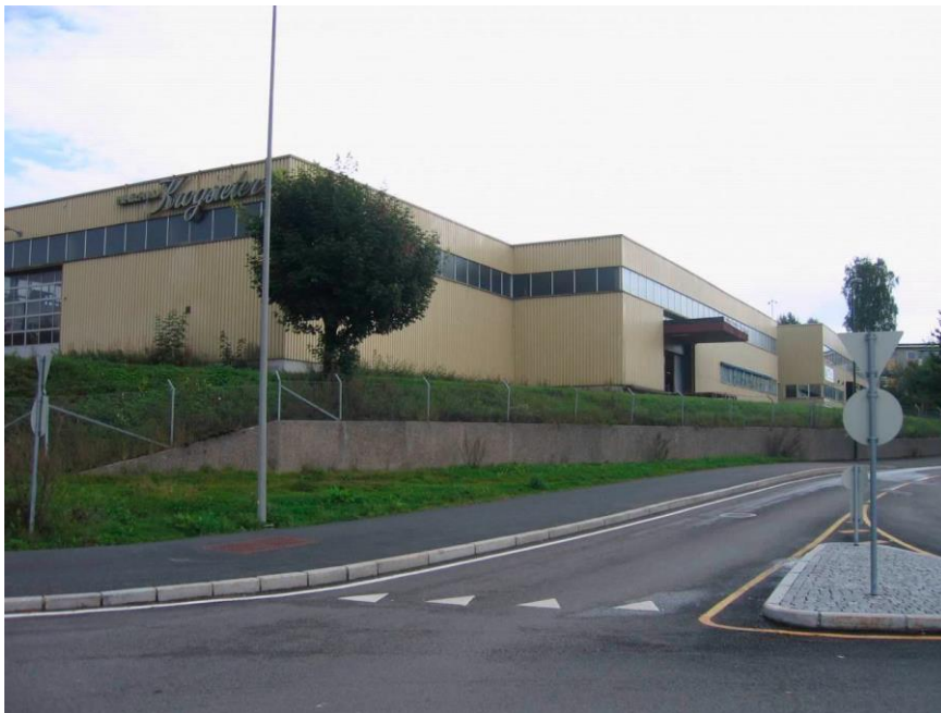
Eksisterende bebyggelse på tomteområdet, sett fra krysset Marcus Thranes vei x Haneborgveien.
