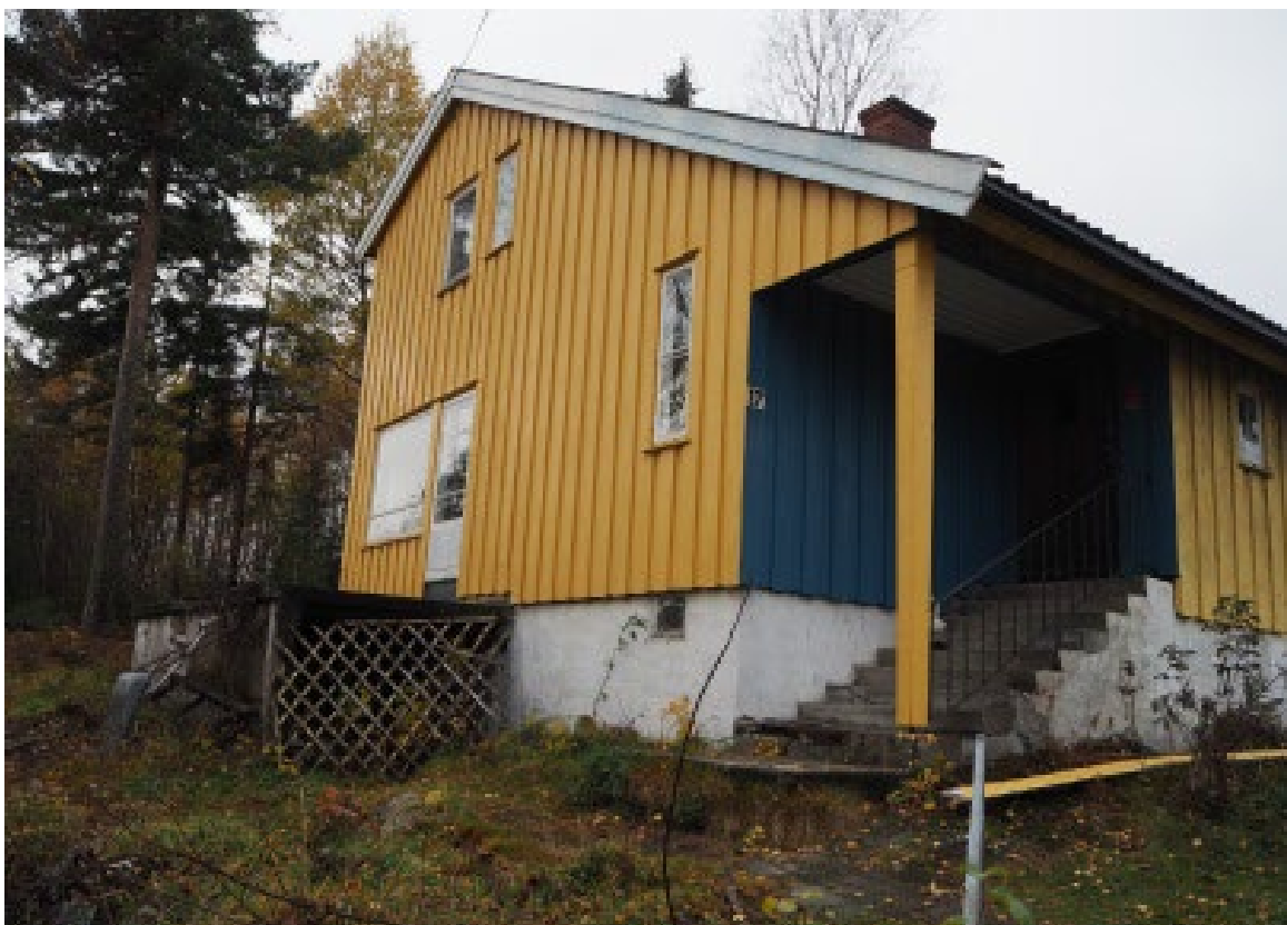
Fig 16 - Ringveien 17 (bevaringskategori A) sett fra sørøst. Foto: Bjørn Johansen, NIKU 2016.
