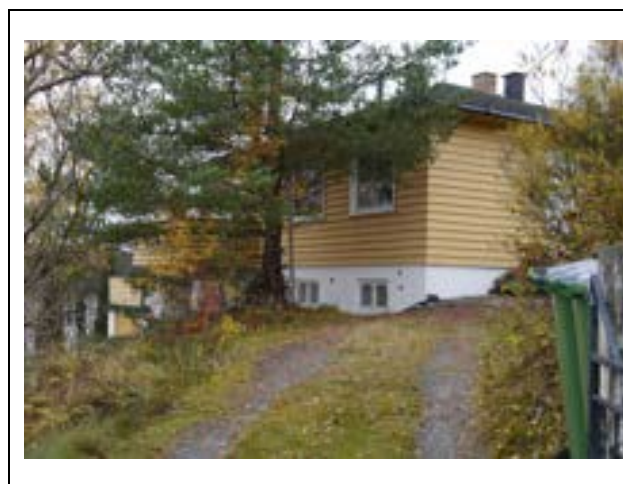
Fig 13 - Blåkollveien 2 (bevaringskategori A) sett fra øst. Foto: nord. Foto: Siv Leden, NIKU 2016.
