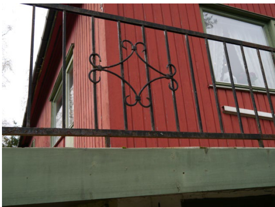
Fig 19 - Ringveien 3, verandarekkverk. Foto: Siv Leden, NIKU 2016
