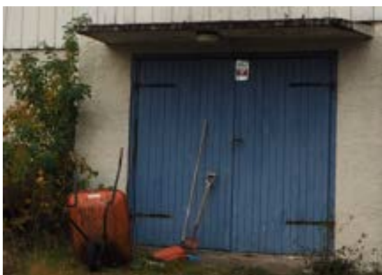
Fig 23 - Bråtaveien 6, garasjeport. Foto: Bjørn Johansen, NIKU 2016
