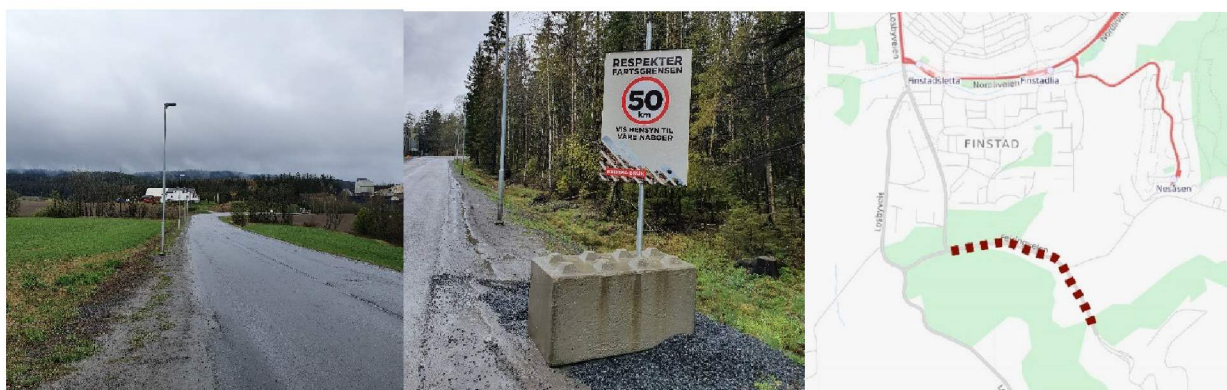
Figur 2.16: Til venstre: Bilder tatt under befaringskjøring av Feiringveien. Til høyre: Oversiktskart over kryssets/strekningens lokalisering. Foto: Norconsult.
