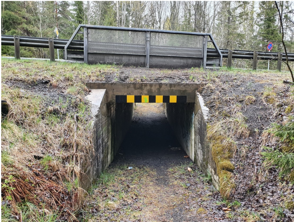
Figur 3.7: Dagens kulvert/undergang under "vei 4201" (Fv.1517). Foto: Norconsult.
