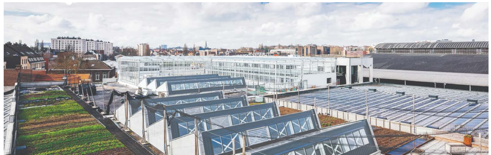
Urban matproduksjon og hydroponics, på tak av eksisterende bygg. Bigh, Brussel.
