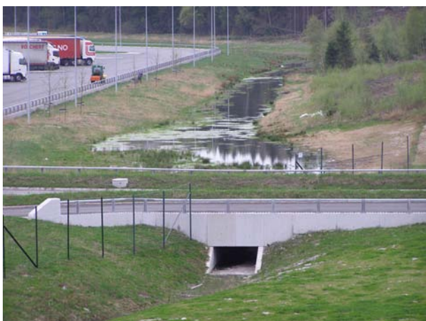
Figur 5. Et større åpent fordrøyningsmagasin er anlagt i et tidligere bekkedeie på tomtens laveste punkt. 75 cm skiller laveste og høyeste vannstand. Slake vegetasjonsdekkede skråninger sikrer god infiltrasjon og sedimentasjon av overflatevann fra parkeringsarealer. Foto: Eivind Saxhaug
