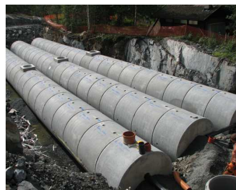
Eksempel på fordrøyning i rørmagasin
