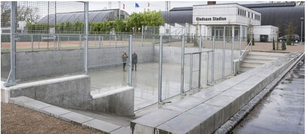
Gladsaxe Sportspark – Regnvannsbassenger etablert som forsenede sportsbaner. Ferdig etablert mars 2015. Foto: Gladsaxe Kommune.
