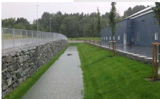
Infiltrasjonsbasseng ved Randaberg Arena. Bassenget er normalt tørt. (foto: Randaberg kommune)
