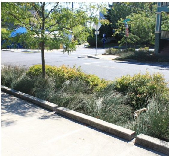
Figur 67: Innløp i støpt betongkant. Infiltrasjonsfeltene i Portland, USA (Foto: Iren Piamonte Kristensen, Statens vegvesen)
