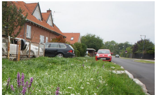
Vadi med underliggende dren med forsinket avledning til avløp. Anlegget er dimensjonert til å magasinere ekstremregn lokalt og utgjør godt 30 prosent av veiens opprinnelige bebygde areal (Rødovre, Danmark).
