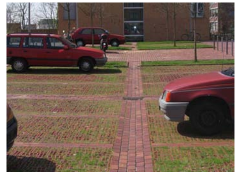
Permeabelt grasarmert dekke på p-plass.
