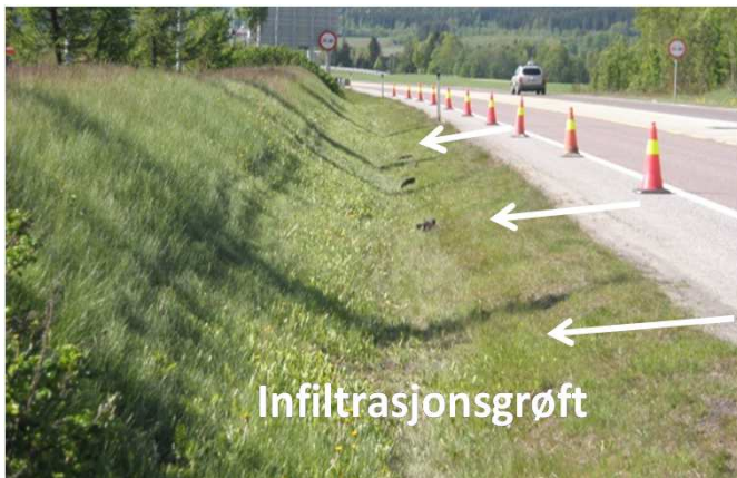
Infiltrasjonsgrøft langs hovedvei (E6 Minnesund).
