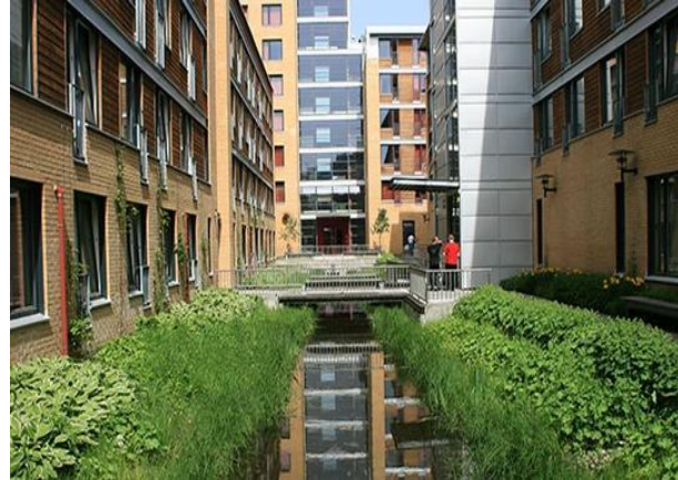
Figur 46: Fordrøyningskanal for overvann i tett bebyggelse, Bjølsen, Oslo. (Foto: Rainer Stange/Dronninga landskap).
