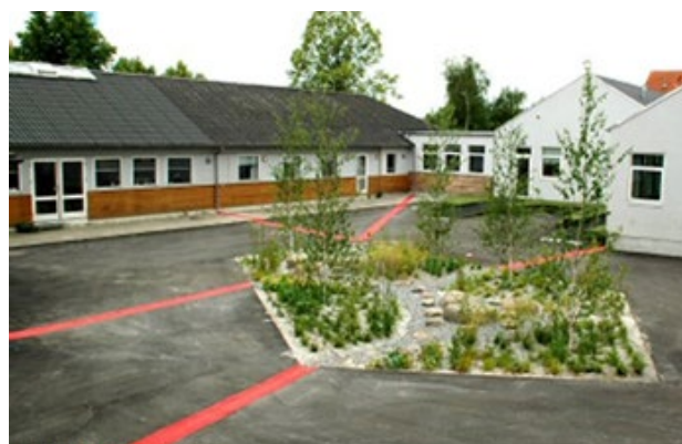
Brøndbyvester- og Brøndbyvester skole. I det nye lekeområdet til Brøndbyvester skole avledes takvannet i renner på terreng. Rennene er koblet til nye grønne anlegg i skolegården (bilde over). Den ene skolegården ble omdannet til en grønn skolegård. I de grønne anleggene med regnbed samt på plenene i området infiltreres vannet (bilde under). Det er adgang til å leke med vannet når det regner og i timene etter et kraftig regnskyll. Kommunen aksepterer at det står opp til 12 cm vann i lekeanleggene i 24 timer. Etter dette skal vannet være infiltrert. Anlegget ble etablert i juni 2013. Foto: Brøndby kommune
