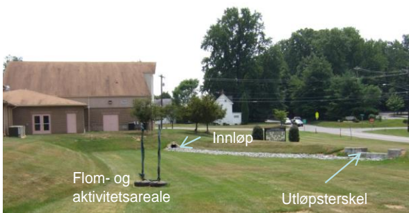
Figur 86: Oversvømmelsesarealer på aktivitetsområde på en skole. Maksimal vannstand ved flom tilsvarer topp utløpsterskel (Foto: Svein Ole Åstebøl, COWI AS)
