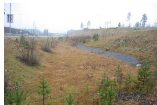
Infiltrasjonsløsning for håndtering av overvann fra vei. Innløp til høyre i bildet. Overløpskum koblet til underjordisk pukkmagasin til høyre som treer i funksjon ved ekstraordinær tilrenning eller tele i bakken (E16 Gardermoen, Jessheim).
