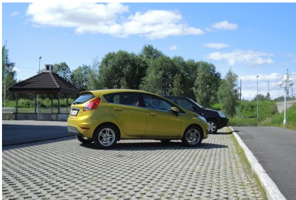
Figur 53: Betongelement som gressarmering på Fjellhamar, Lørenskog (Foto: Yvona Holbein)
