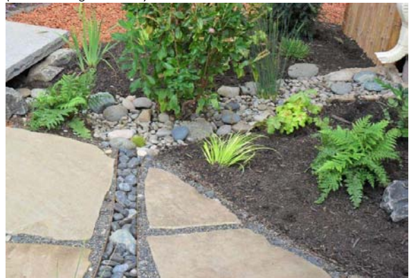
Figur 16: Utløpet fra takrenne kan lages pent selv om det renner på bakken (Foto: Erling Holm ©)
