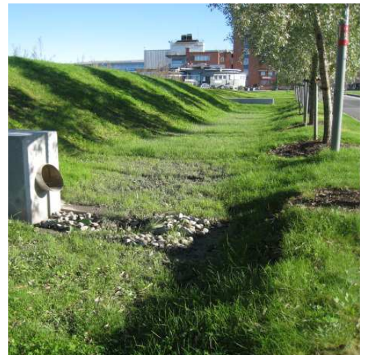
Langstrakt filterbasseng for gatevann plassert i et parkområde i by (Fornebu). Innløpet sees i forgrunnen. Anlegget har ikke forsedimenteringsenhet utover sandfang i gata.
