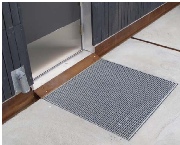
Figur 3. Vann fra tak og gangarealer. Horisontale renner gir god tilpassing til bygningene. Foto: Eivind Saxhaug
