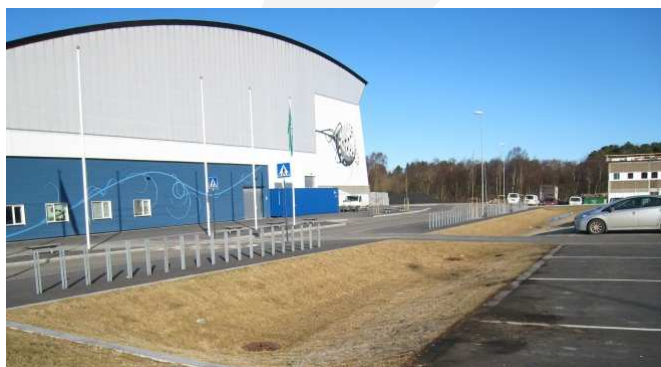
Nedsenket infiltrasjonssone for overvann fra P-plass ved Randaberg Arena (foto: Randaberg kommune)
