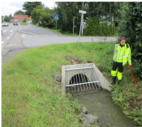
Figur 73: En bekkelukking/kulvert (Foto: Harald Løvstad)
