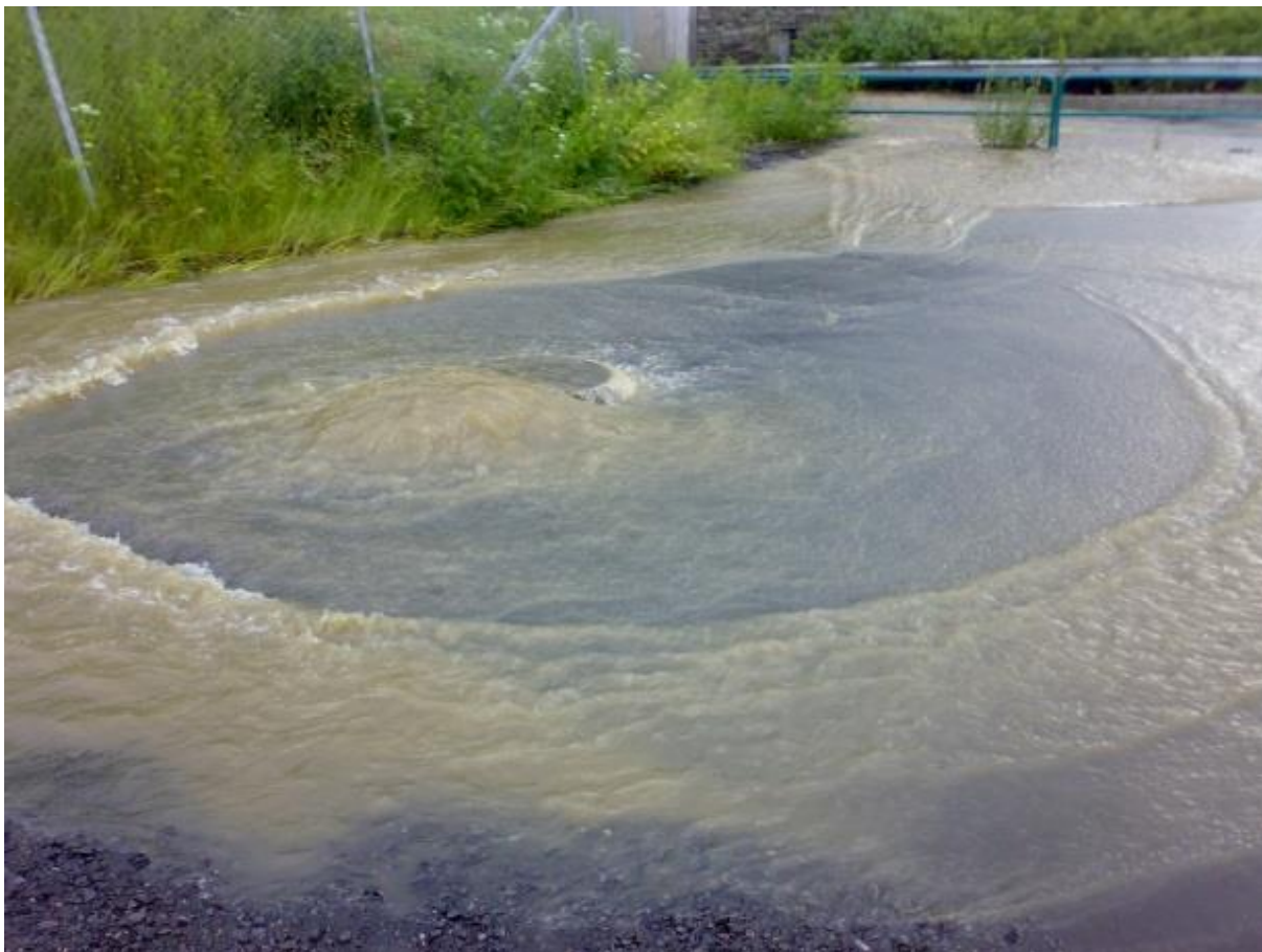
Figur 20. Oversvømmelse der overvann, blandet med avløpsvann, renner ut av en kum ved Fjellhamar stasjon (Foto: Kommunalteknikk, 2007).
