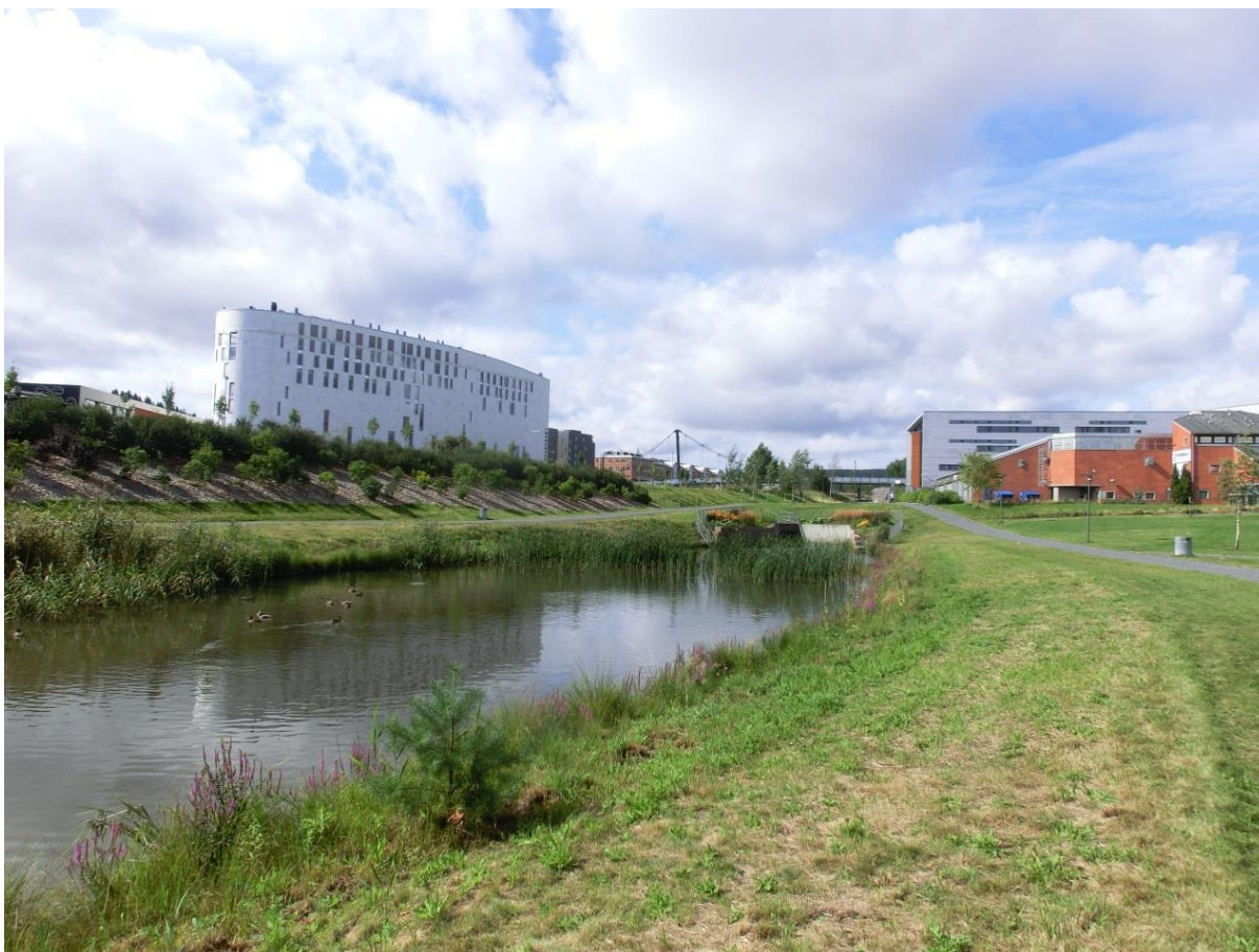
Figur 28: Rensedammen for overvann i Rådhusparken. All overvann fra området rundt Skårersletta, inkl. eventuell overløpsdrift og vann fra veisluk på RV 159, sendes til denne rensedammen, som skulle være den første av flere trinn.
