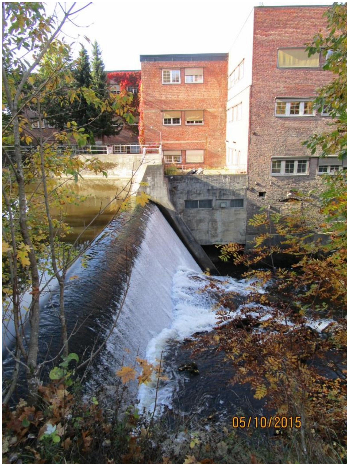
Figur 6: Demningen ved Icopal på Fjellhamar påvirker vannstanden oppstrøms i Fjellhamarvassdraget frem til Struterud (Foto: Yvona Holbein, Lørenskog kommune, 2015).
