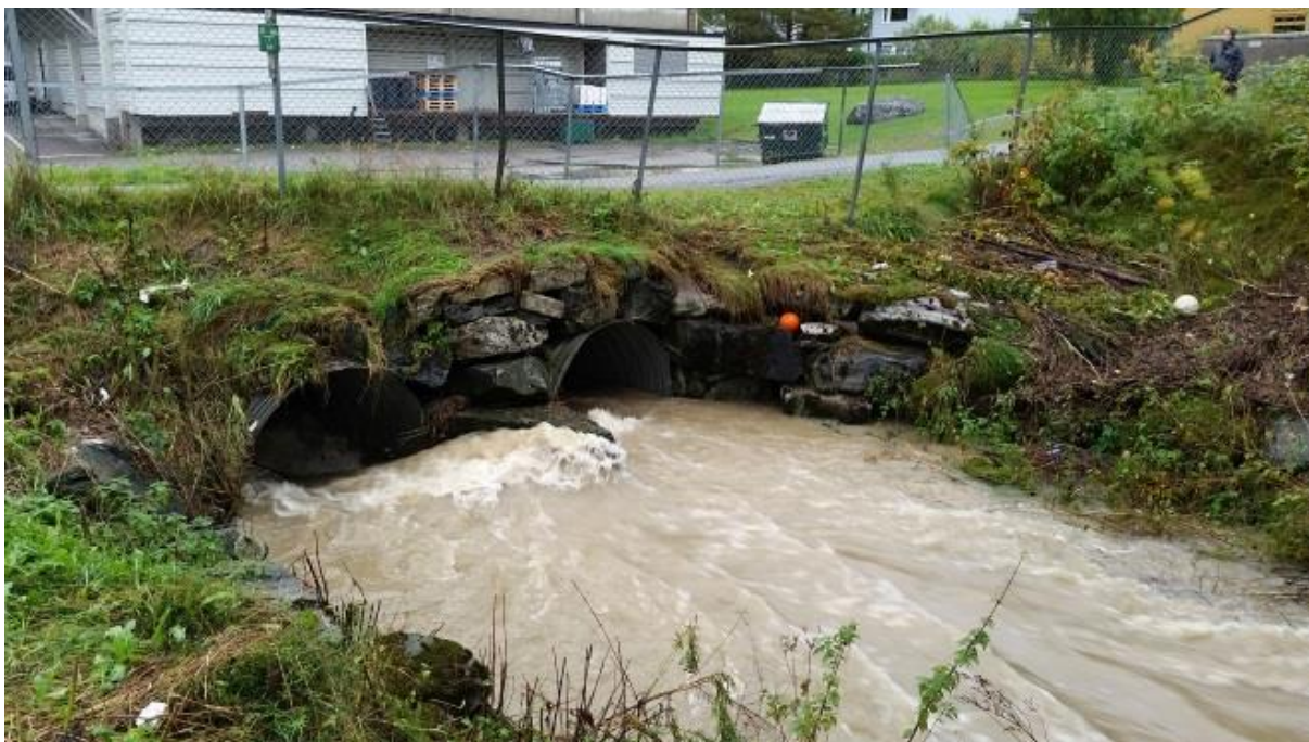
Figur 8: Kulverter for Finstadbekken ved Nordliveien 17. september 2015 (Foto: Yvona Holbein, Lørenskog kommune, 2015).
