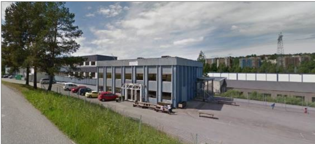
Figur 2: Industriveien 7a sett fra sør (skolebygg og uteareal)
