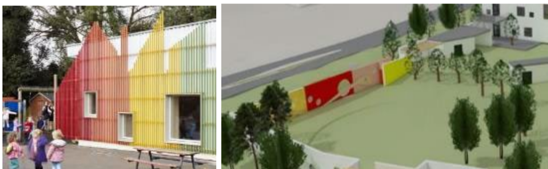
Figur 33: Eksempler på støyskjermer med elementer som kan bryte opp høydevirkning og aktivisere uteområder.
