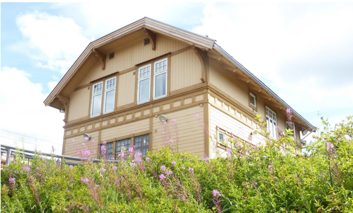
11. Stasjonsbygningen på Lørenskog stasjon (foto: Siri Adorsen, Lørenskog kommune)
