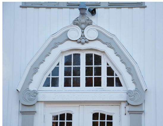
38. Inngangspartiet på Fredheim skole (foto: Siri Adorsen, Lørenskog kommune)
