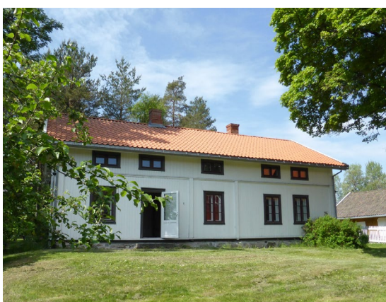
26. Mellom-Hammer, våningshus (foto: Siri Adorsen, Lørenskog kommune)
