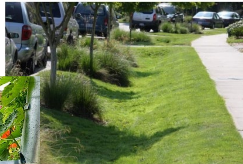
Figur 21: Fordrøyning og infiltrasjon i gresskleddeskanne langs gater, kalt vadi (Foto: Erling Holm ©)
