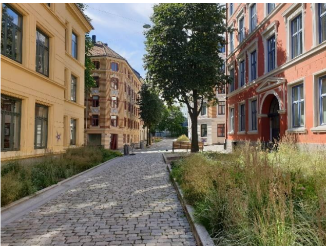
Deichmans gate, Oslo: Gate oppgradert med regnbed for overvannshåndtering.
