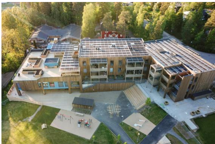
Løkenåsveien 45: Moderne omsorgsboliger og barnehage i samme bygg. God kvalitet i utforming og materialbruk.
