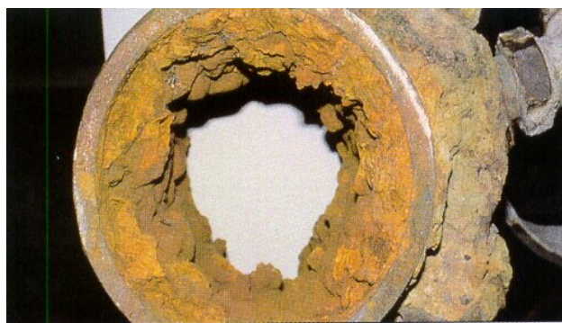
Gammel vannledning som skiftes ut
