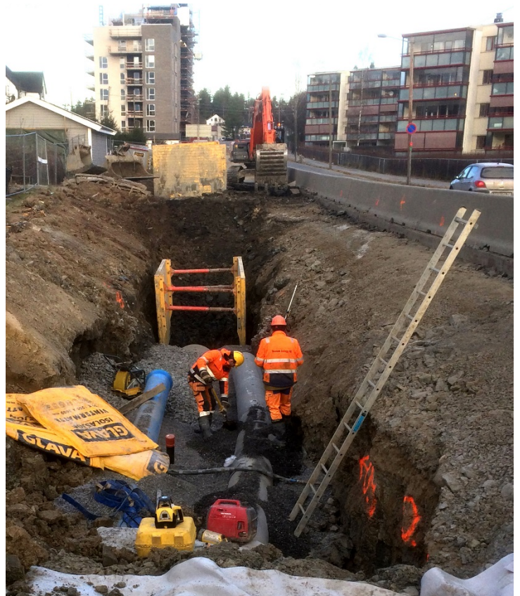
Legging av VA-nett langs Losbyveien (foto: Thomas Lundeby)
