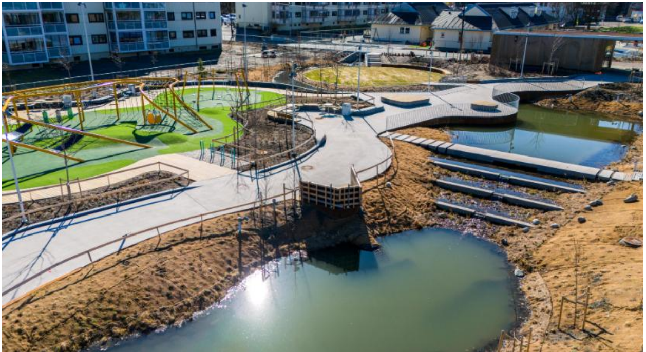
Skårerparken, bygget basseng som håndterer overvann
