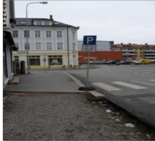
Manglende avsperring av arbeidssted.
