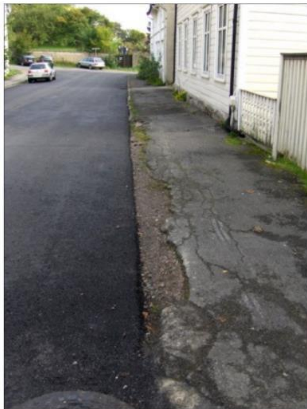
Manglende prioritering av gående ved dekkelegging.
