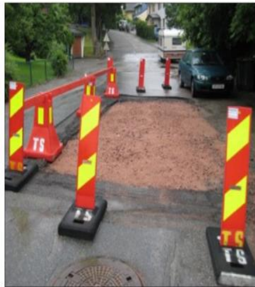
Sikring av gravested.
